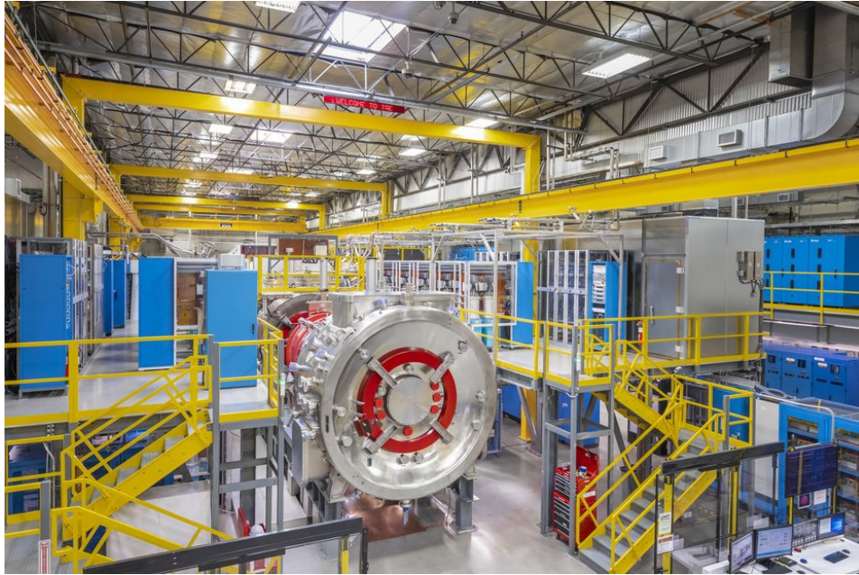
Fig 7 - La machine NORMAN en construction à TAE en Californie (USA)
